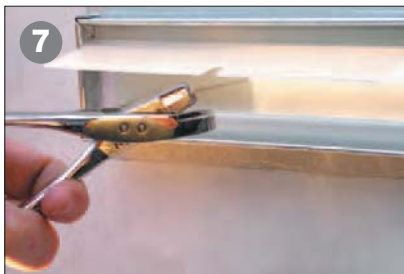
7 Einfaches und passgenaues Ausschneiden der Abschlusskappen für Kabelaustritte mit original Spezialzange oder sonstigem geeigneten Werkzeug.
