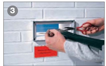
3 Nach beendeter Kabelinstallation, Ausschnitt der Abschlusskappen nach Erfordernis
