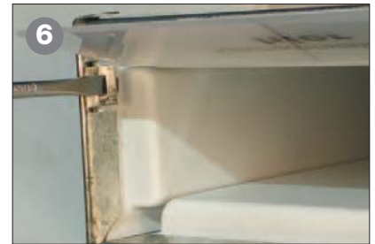
6 Hochklappen und waagrechtes Positionieren der Abschlusskappen durch Aufbiegen der Blechlaschen. Nach Beendigung der Kabelinstallation die Blechlaschen wieder zurückdrücken und die Abschlusskappen in eine horizontale Position schwenken.
