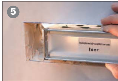
5 Vermitteltes Einsetzen der FST-Kabelbox im Gipsbett aus Gips-spachtel. Danach vollständig und in Wandtiefe verfügen.
