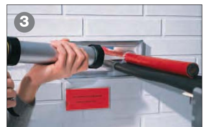
3 Nach beendeten Kabelnachinstallationen, beidseitiges rauchdichtes Abspritzen der Kabeldurchtritte mit dauerelastischem Dichtstoff
