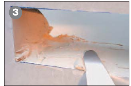
3 Ausspachteln der Bauteilleibungen mit Gips.
