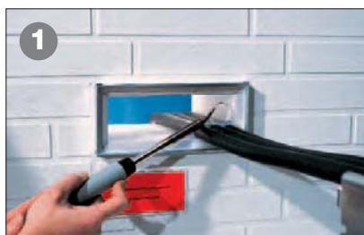
1 Öffnen der Abschlusskappen nach Erfordernis (thermisch oder mechanisch)
