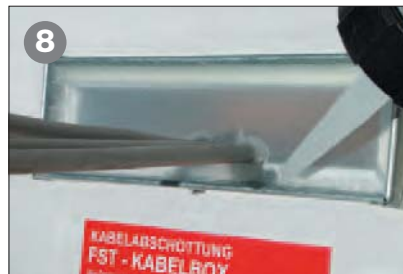
8 Inbetriebnahme nach beendeter Kabelinstallation durch rauchdichtes Abspritzen der Kabel-durchtritte durch die Abschlusskappen und der Anschlussfugen zum Gehäuse mit herkömmlichen dauerelastischem Dichtstoff ohne spezielle Brandschutzfunktion . Anbringung der Schottkennzeichnung.
