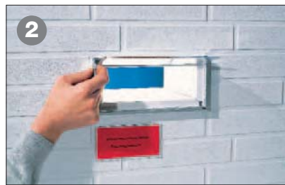
2 Zur Kabelinstallation die werkseitig fest mit den Kabelabschottungen verbundenen Abschlusskappen durch Aufbiegen des Haltestegs ausrichten
