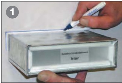
1 Anzeichnen der äußeren Abmessung an einer Außenseite der Gipskartonwand.
